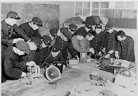
実験室でのラジオ受信機の組立調整の様子
